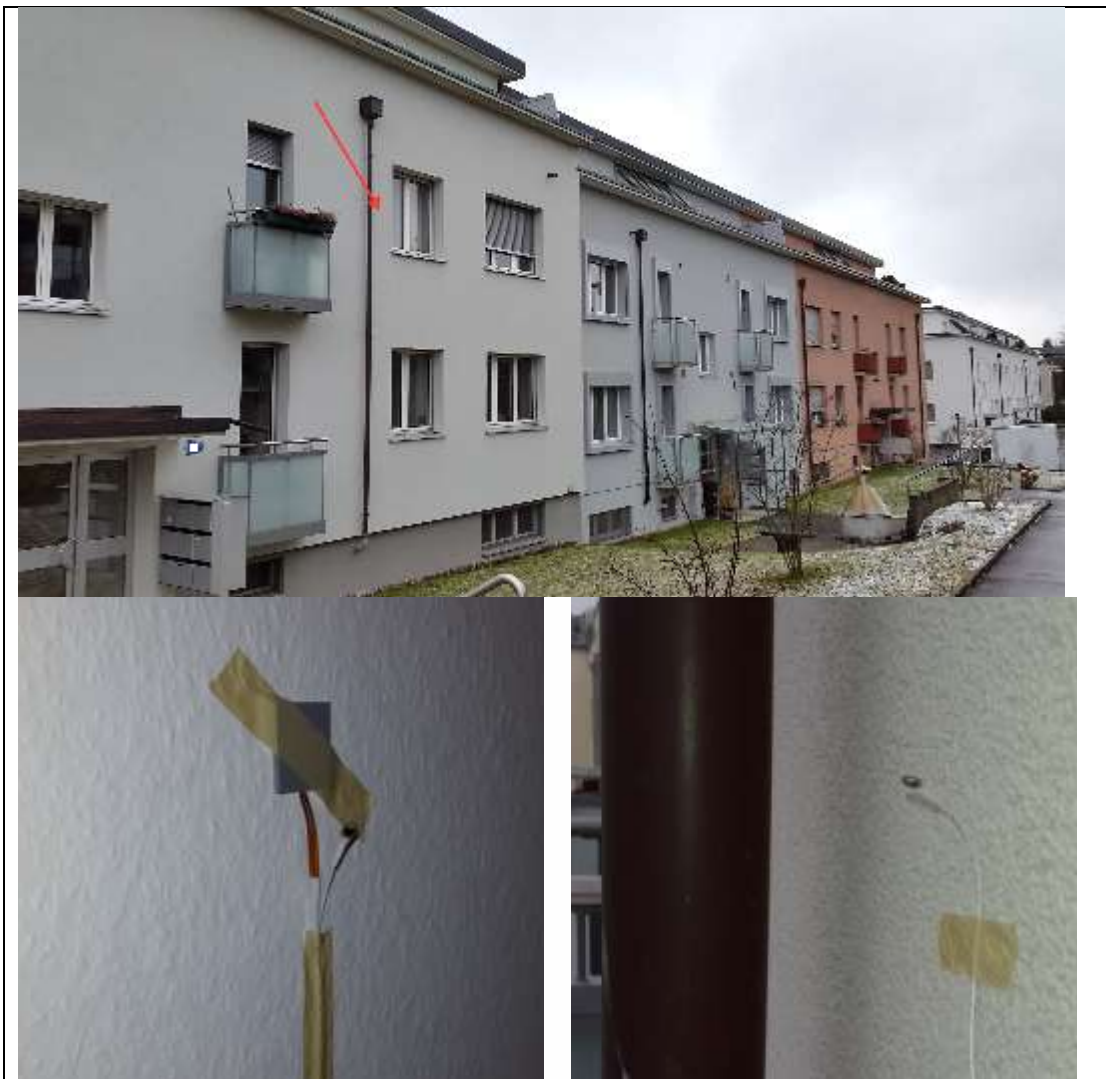
Abbildung 1: Wärmeflussmessungen zur U-Wert Bestimmung. (Oben) Messobjekt – Pfeil kennzeichnet die Messstelle. (Unten) Links: Innenmessung / Rechts: Aussenmessung
