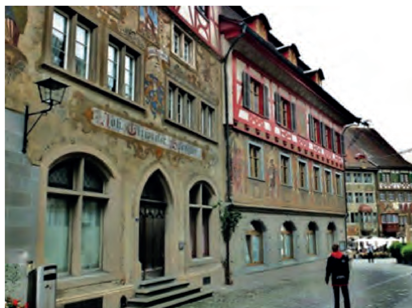
Messung Status Quo vor energetischer Sanierung
